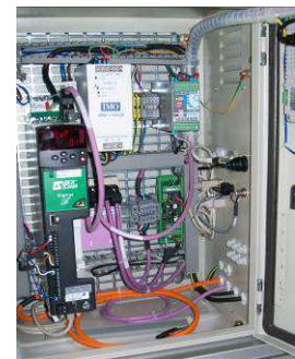
Vue du coffret : composants de commande et bus de terrain
